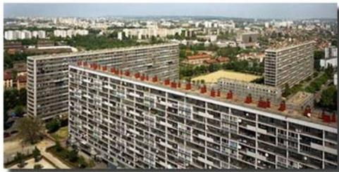
Il faut construire vite et pas cher pour répondre à la demande. Pour ce faire, la technique de la préfabrication en béton est utilisée et l'assemblage se fait sur place à l'aide d'une grue. Le déplacement d'une grue le long d'un rail (chemin de grue) permet de gagner du temps et de construire des immeubles plus longs. Ce type de procédé ne permet d'obtenir que des formes simples (barres ou tours) et les immeubles
