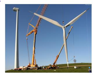
Le rotor est constitué de 3 pales et est relié à la nacelle par son moyeu. Il transforme l'énergie cinétique du vent en énergie mécanique de rotation.
